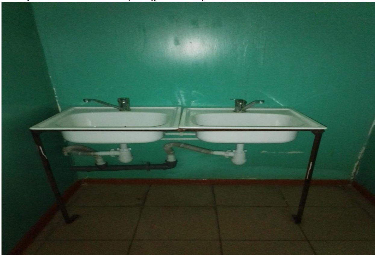
Санитарно-гигиенические помещения (умывальник)
